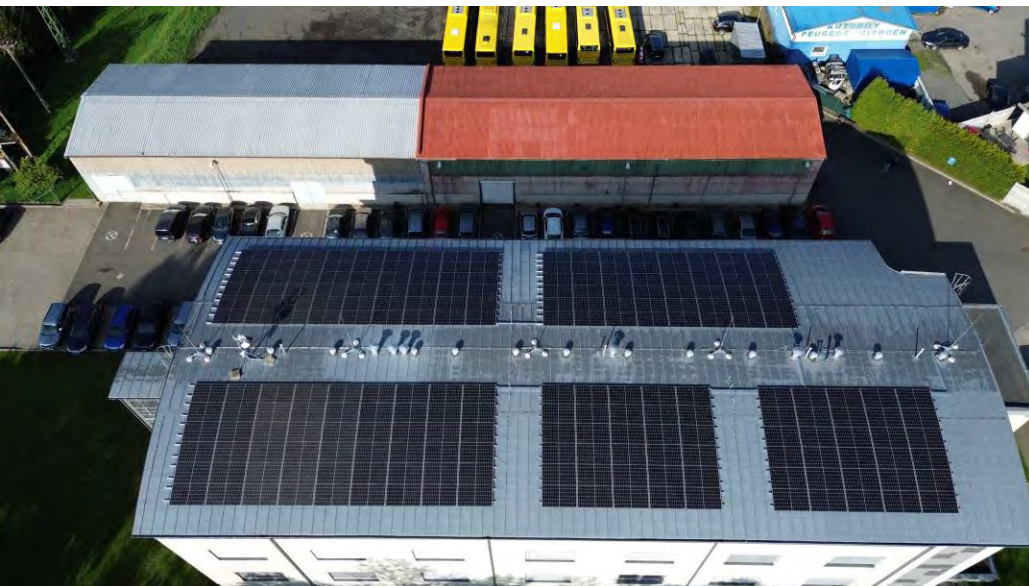
Rožnov pod Radhoštěm 99,4 kWp (110 kWac) FVP Lepton 460Wp, Invertory HUAWEI 50KTL
