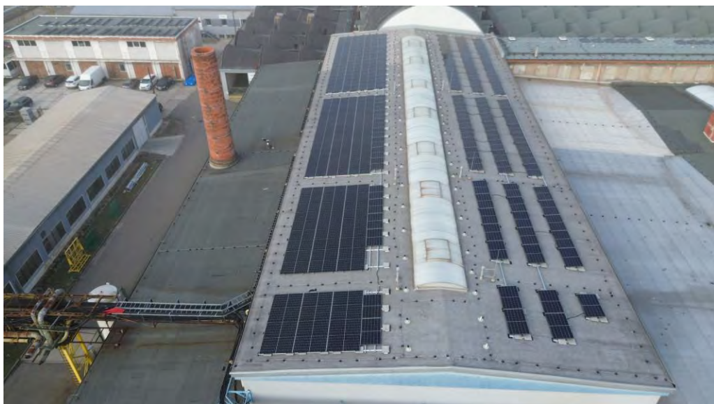
Valašské Meziříčí 379 kWp (320 kWac) FVP Lepton 460Wp, Invertoy HUAWEI 40KTL
