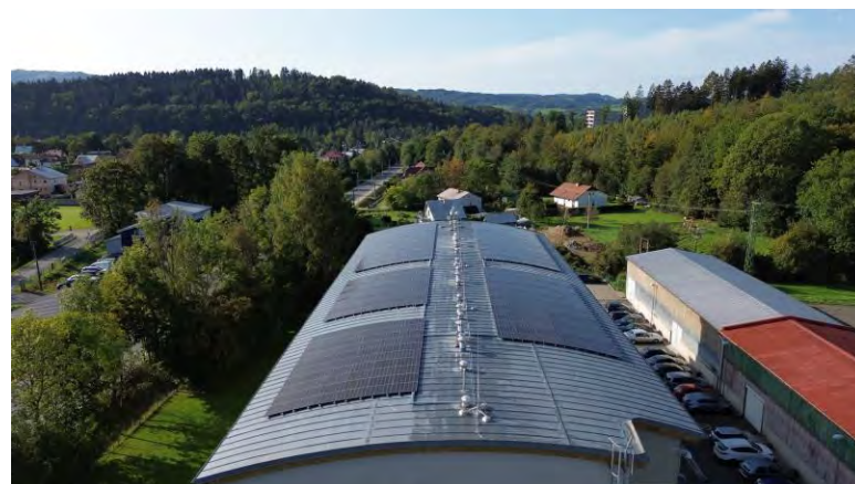
Rožnov pod Radhoštěm 99,4 kWp (110 kWac) FVP Lepton 460Wp, Invertory HUAWEI 50KTL
